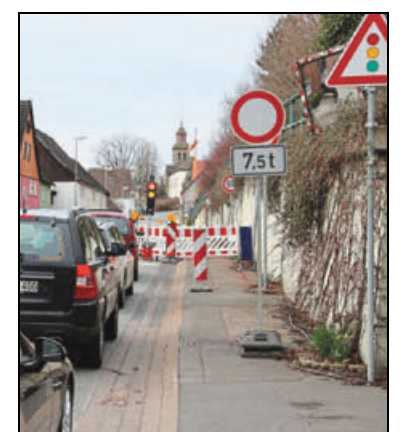
Die Stützmauer soll saniert werden. Foto: Pape/Archiv
